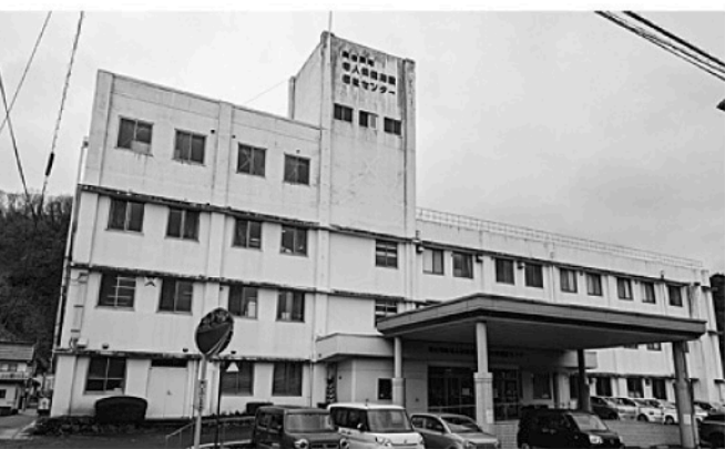
旧仁多病院の部分が解体され、縮小される介護老人保健施設
